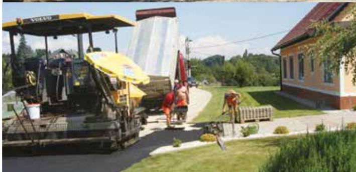
Die Generalsanierung der Turningbergstraße konnte ebenfalls mittels Stabilisierung des Unterbaues, Aktivierung der Entwässerung, Einbau von 2 Ausweichstellen im Bereich der Ansteigung im Wald sowie Asphaltierung der Bankette im Bereich der bisherigen Engstelle – Blumen Kurz – bis zur Kreuzung mit der Aschnullstraße fortgeführt werden. Die Angleichung der Pflasterung im Bereich des Betriebes erfolgte mit teilweiser Abgeltung dieser Eigenleistung.
